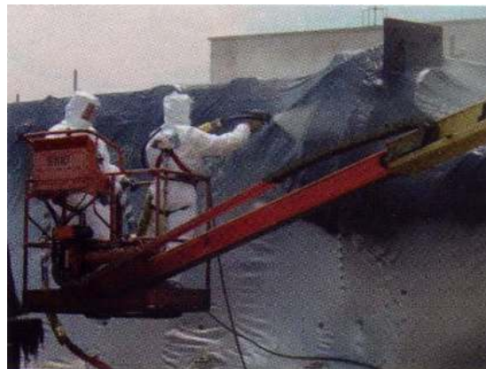
InstaCote ポリウレアコーティングを噴霧し、梱包が完成
