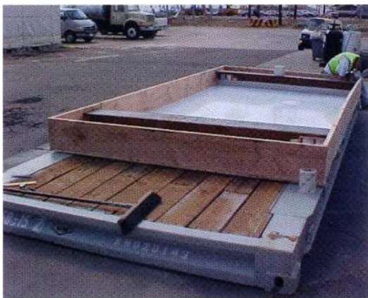
重さ 44t の圧縮機を載せる土台
