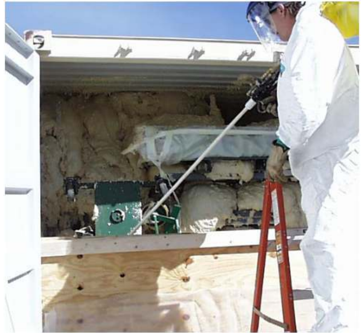
ロッキーフラッツの作業員は、構造発泡剤を用いて貨物用コンテナの内部を遮蔽し固定している
