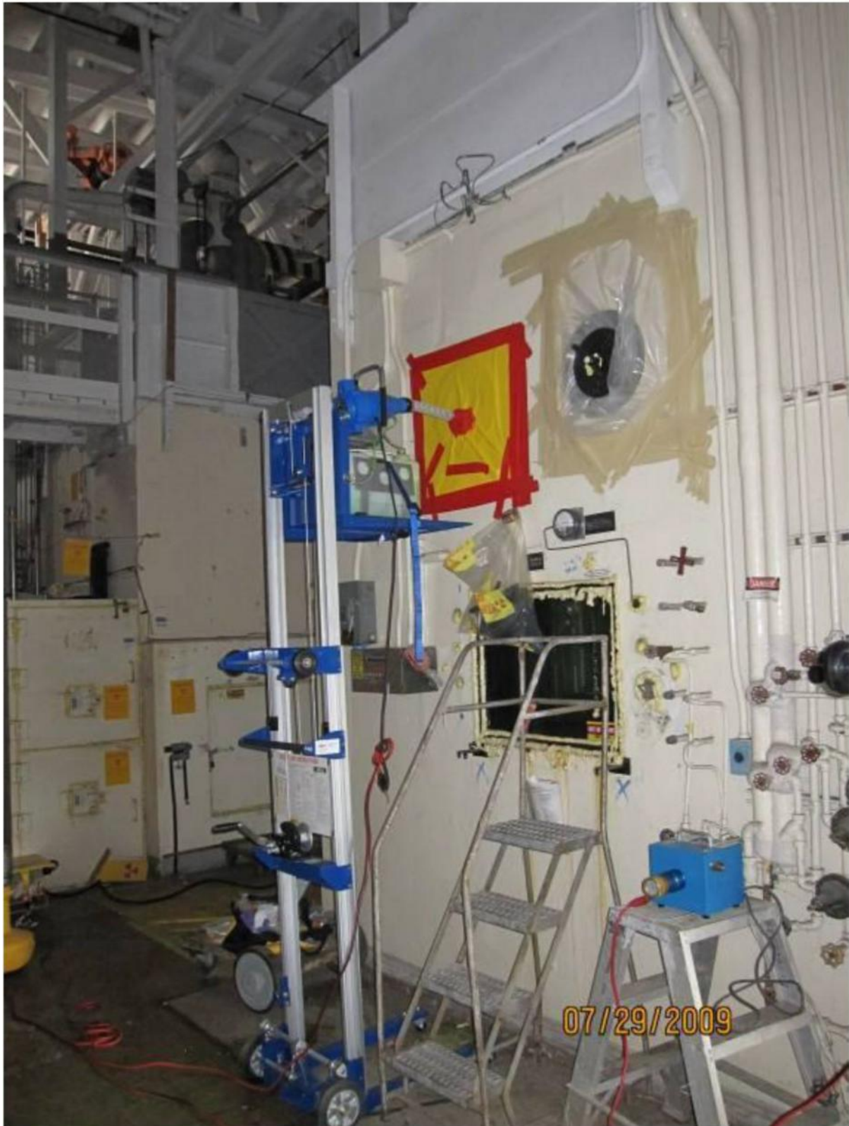
操作装置ポートを経由してホットセルのバンク 1 を噴霧
