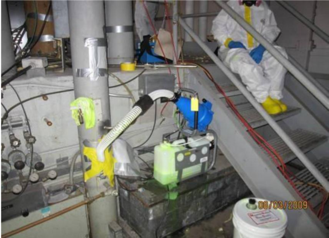
セル換気ダクトを経由してセルバンク 2 に CC Wet を注入
